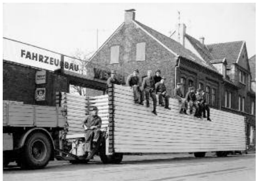
Spezialtransporter mit zweiteiligem Fahrgestell (20 t Gesamtgewicht) für die 18 m langen Speichen des Riesenrades der Schaustellerfamilie Willi Bruch und Söhne. Von links: Hans Röttger, Alfred Dahmen, Wilfried Rohde, Hans Otto Wetzel, Harry Bruch, Jochem Drekopf, August Heinze, Karl Heinz Röder, Werner Winkel, Ralf Korte
