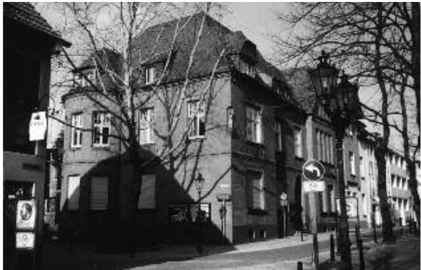
Das 1909 fertig gestellte neue Pastorat an der Kirchgasse 1 (früher Markt 14)
