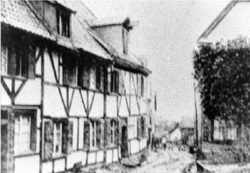
Um die Wende vom 19. zum 20. Jahrhundert sahen die Häuser an der Dorfstraße in Homberg recht baufällig aus
