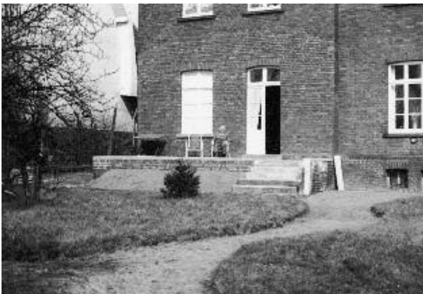
Die Rückseite des Pfarrhauses mit der Terrasse, deren hölzerner Überbau bereits abgerissen wurde. Im Vordergrund die abgerundeten Rasenstücke, von der Familie Bever „Koteletten“ genannt
