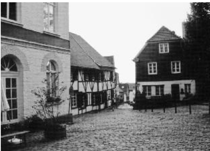
Fachmännisch hergerichtet und modern ausgestattet bieten die einst baufälligen Häuschen an der Dorfstraße heute begehrte Wohnobjekte
