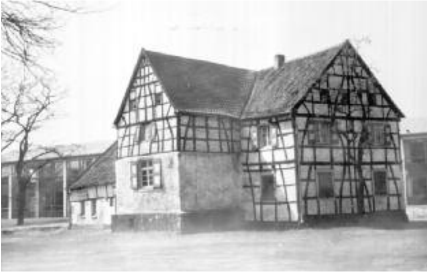
Das neue Schulgebäude wurde auf dem Gelände des uralten Hofes Hinüber errichtet. Hier steht das Fachwerkhaus noch vor der fast fertigen Schule. Leider wurde es 1956 niedrigerissen
