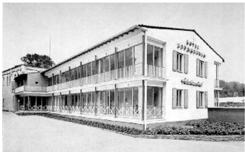
Das von Professor Emil Fahrenkamp 1955 entworfene und neben dem Schwimmbad errichtete „Hotel Krummenweg“, das über 38 Betten verfügte
