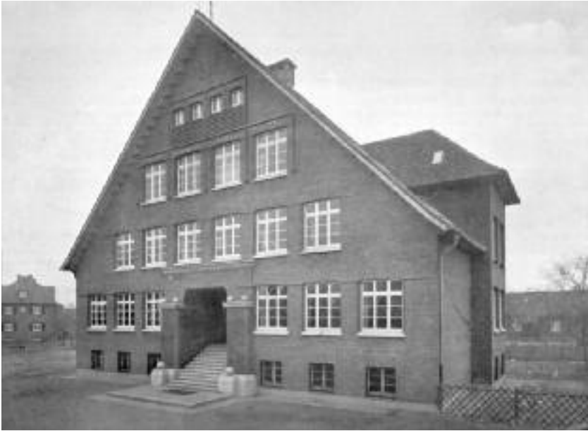
Das im Jahre 1926/27 errichtete Gebäude der ersten Johann-Peter-Melchior-Schule an der Speestraße. Es musste 1955 wegen Baufälligkeit abgerissen werden. An der Westseite ist deutlich einer der Risse im Mauerwerk zu erkennen. Links das Wohnhaus des Hauptlehrers (heute „Lintorfer Reformhaus“)
