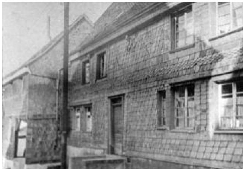
Das Haus „In der Laub“ war mit seiner Schieferverkleidung typisch für die entlang der Dorfstraße stehenden Wohngebäude
