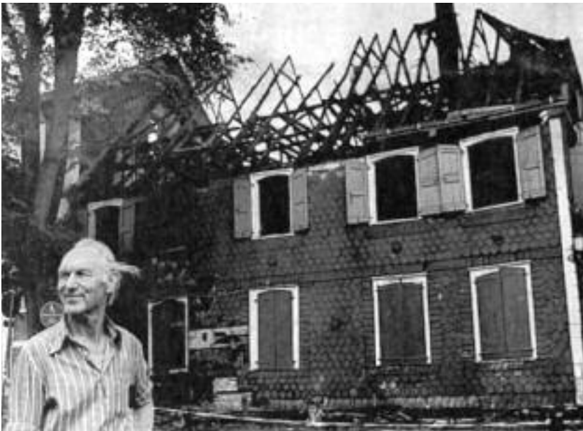
Bis auf die Umfassungsmauern wurden das mit Schiefer verkleidete Fachwerkhaus und das Nebengebäude am Krummenweg durch Feuer vernichtet. Harry Schröder, der fast 30 Jahre lang bei der Familie Doerenkamp arbeitete, ist tief betroffen RP-Foto: Reiner Klöckner · Rheinische Post vom 2.6.1989
