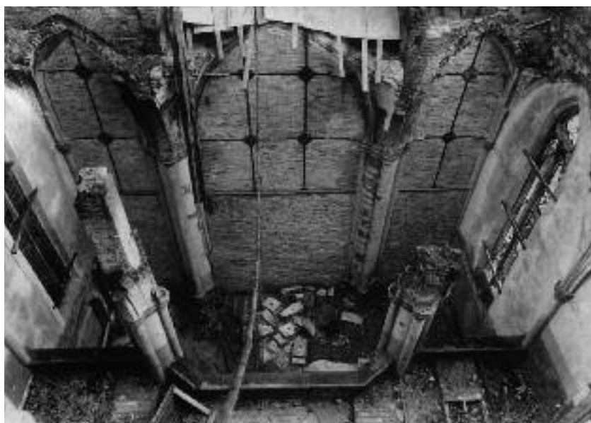
Die teilzerstörte Kirche St. Peter und Paul im Jahre 1945. Man erkennt die aufgemauerte Trennwand zwischen dem zerstörten und unzerstörten Teil des Hauptschiffes. Auf der Trennwand die von Kaplan Rosenbaum und Helfern angebrachten Zinkbleche. Durch den zerstörten Teil der Kirche läuft das intakt gebliebene Stromkabel für den Antrieb der Glocken im unzerstörten Westturm
