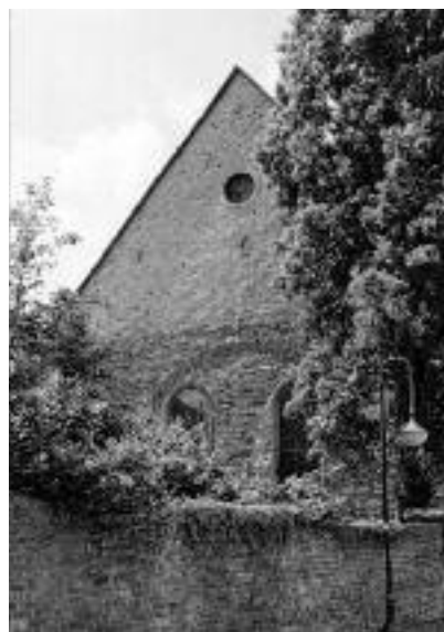
Der Ostgiebel des aus Bruchstein und Ziegelmauerwerk bestehenden Kirchenbaues von 1668–1688. Deutlich ist der Bogen aus Ziegelsteinen zu erkennen, der auf einen ursprünglich geplanten Chorabschluss schließen lässt
