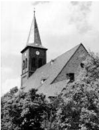
Die Stadtkirche von Osten aus gesehen. Im Vordergrund der Sakristeianbau von 1927
