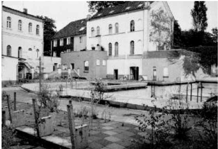
Das Schwimmbad im Oktober 1980. Etwa ein Jahr nach der Schließung hat die Natur bereits begonnen, sich das einst so gepflegte Gelände zurückzuerobern
