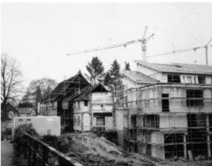
Richtfest für das neue Hotel im November 2003. Links vom Hotelneubau die zur Restaurierung eingerüstete historische „Kutscherkneipe“
