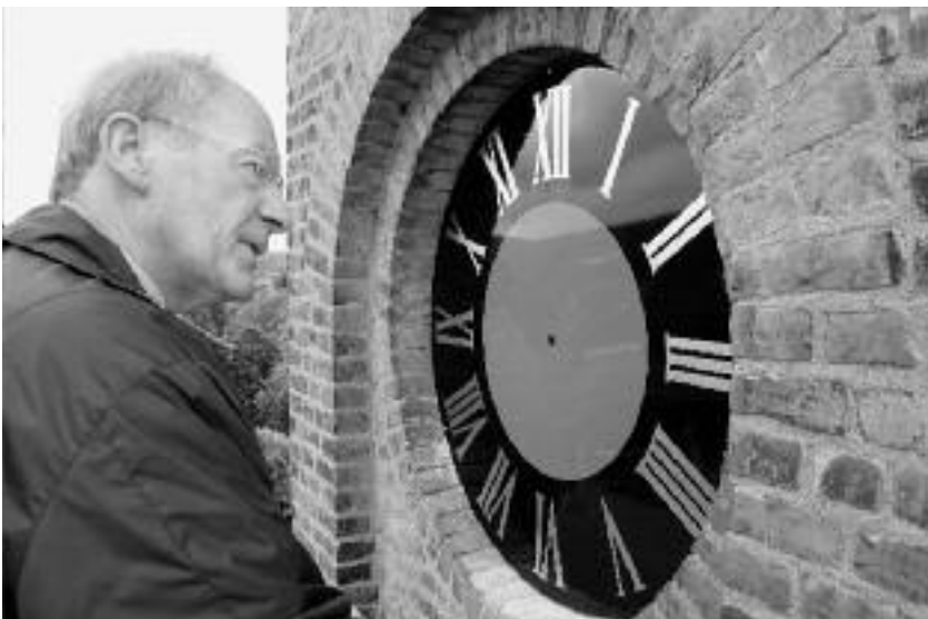
Pater Chris Aarts beim Einbau der neuen Turmuhr von St. Anna am 31. August 2004
